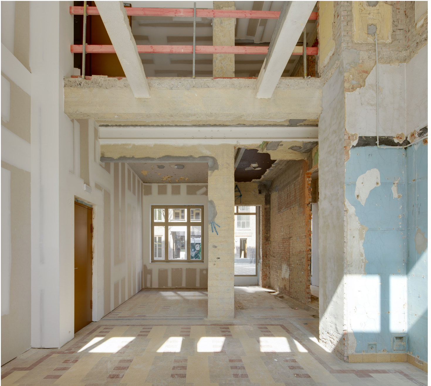
Zicht op de mezzanine en de achterzijde van het pand.
