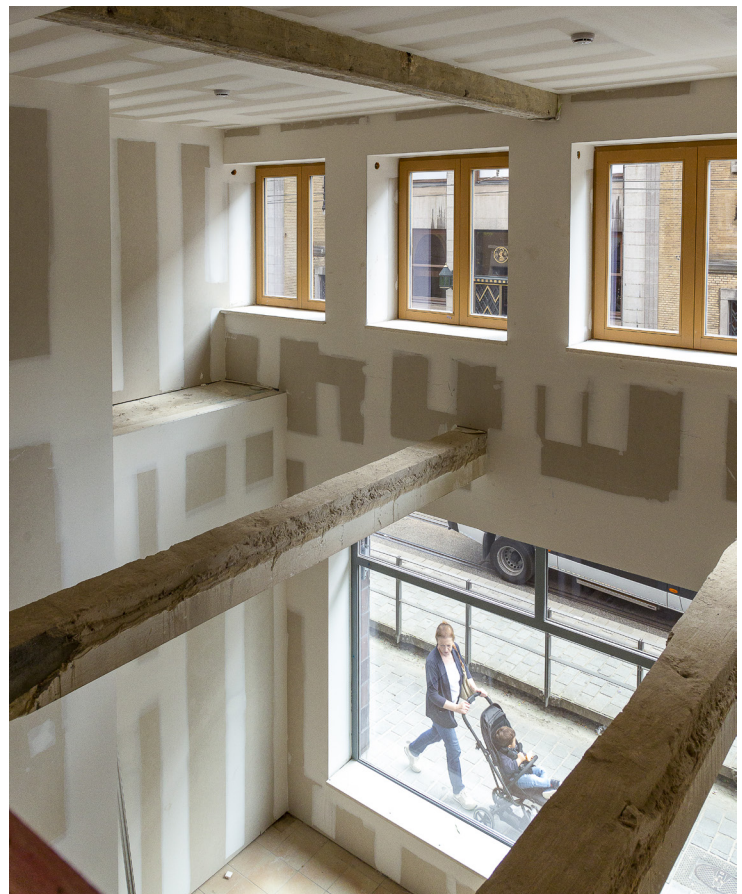
Zicht vanop de mezzanine.
