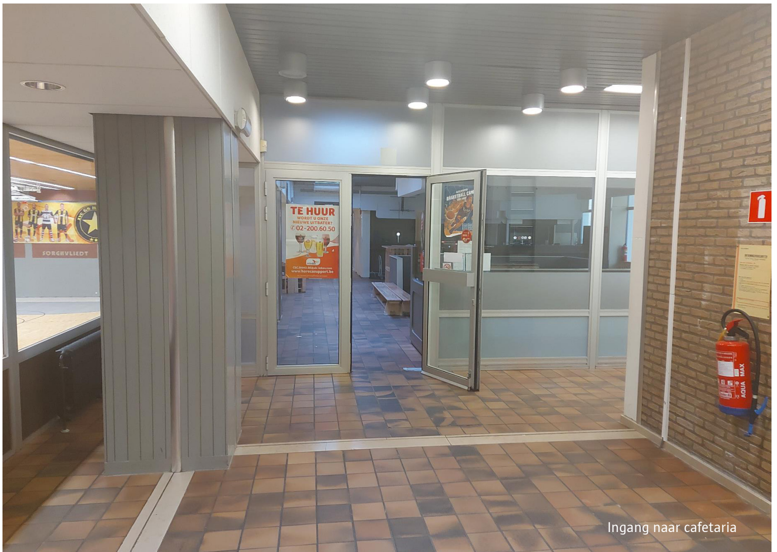
Achteringang naar drankenberging en brandtrap naar feestzaal
