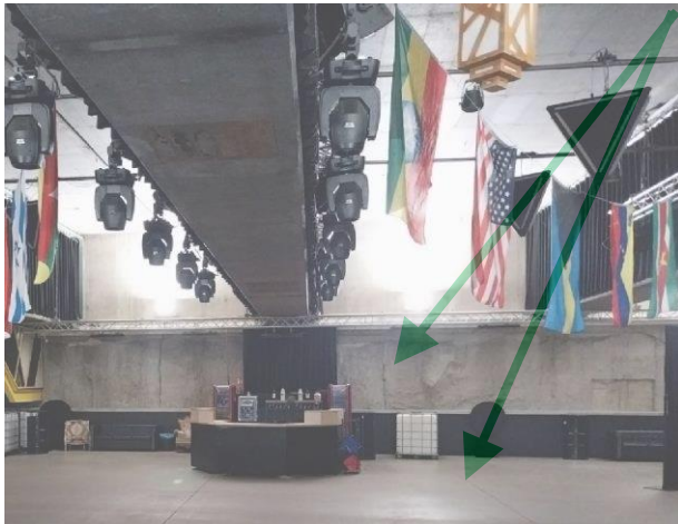
Figuur 4: 00.15 polyvalente zaal binnenruimte: betonnen muren en vloeren: geen asbest
