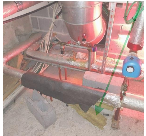
Figuur 9: 01.08 stooklokaal: buisisolatie steenwol: geen asbest
