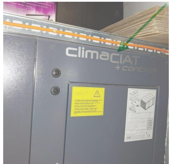
Figuur 11: 01.03 algemeen: CLIMACIAT luchtverversing: geen asbest
