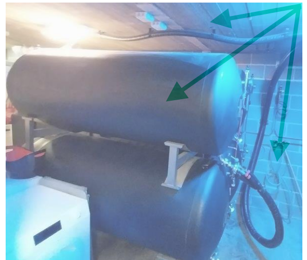
Figuur 7: 00.23 opslag: betonnen vloer en plafond, technische dranken installatie: geen asbest
