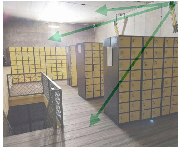
Figuur 5: 00.15 lockerruimte: betonnen muren, plafond en vloerbekleding uit hout: geen asbest
