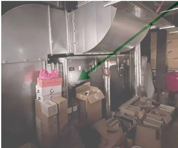
Figuur 12: 01.03 algemeen: CLIMA CV: geen asbest
